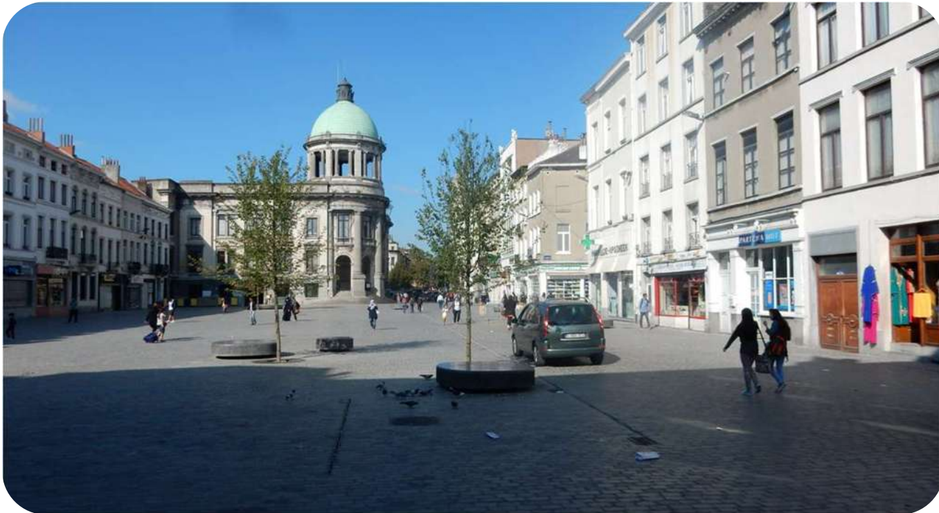
Réaménagement de la place Communale de Molenbeek (2013-2014) – auteur de projet 'a practice'
